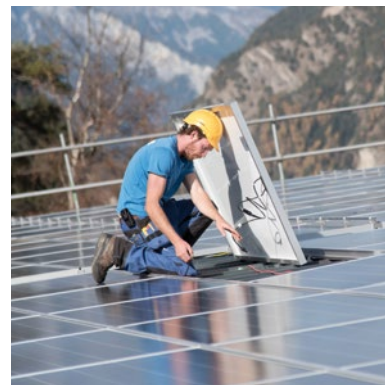
Ein Eternity-Kunde, die Firma hassler energia alternativa ag, bei der Installation einer Photovoltaikanlage.
